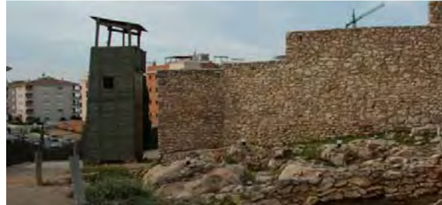
Vista d'un tram de la muralla reconstruïda i de la torre de fusta romana
